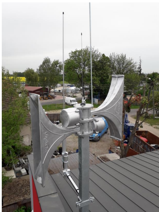
Rysunek 18. Tuby nowoczesnej syreny elektronicznej wraz z systemem anten nadawczo - odbiorczych.
