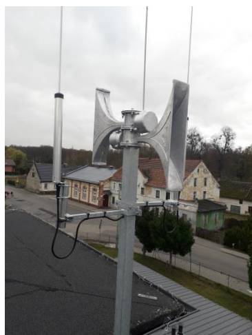
Rysunek 14. Zainstalowanie nowej syreny alarmowej w Szczodrem
